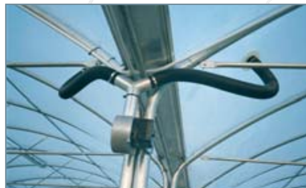
il sistema di ancoraggio è pratico e consente la totale smontabilità
