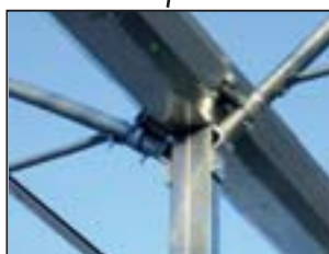
particolare raccordo pilastro-arcata
